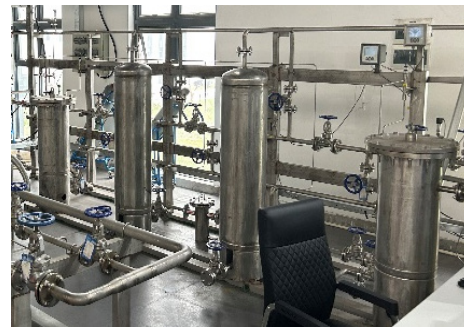
图 3 实验平台净化设备照片
