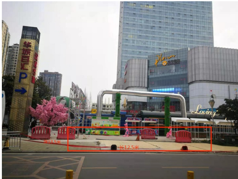
图1 现场实景与项目定点
