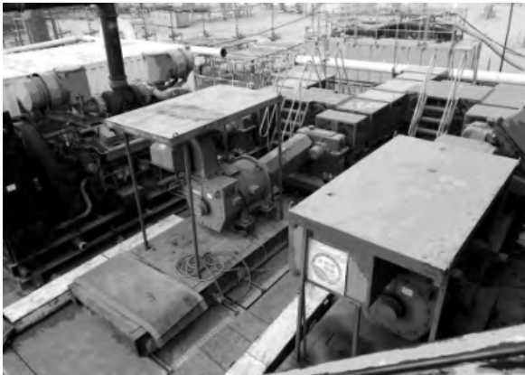
图 1 钻井设备的安装现场
