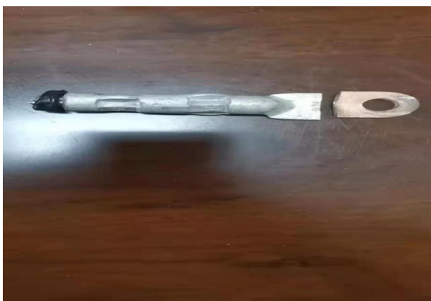
图 2 线夹断裂故障
